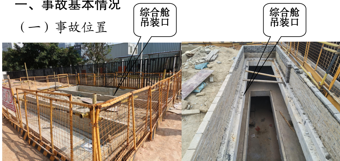
图1 综合管廊综合舱吊装口3
