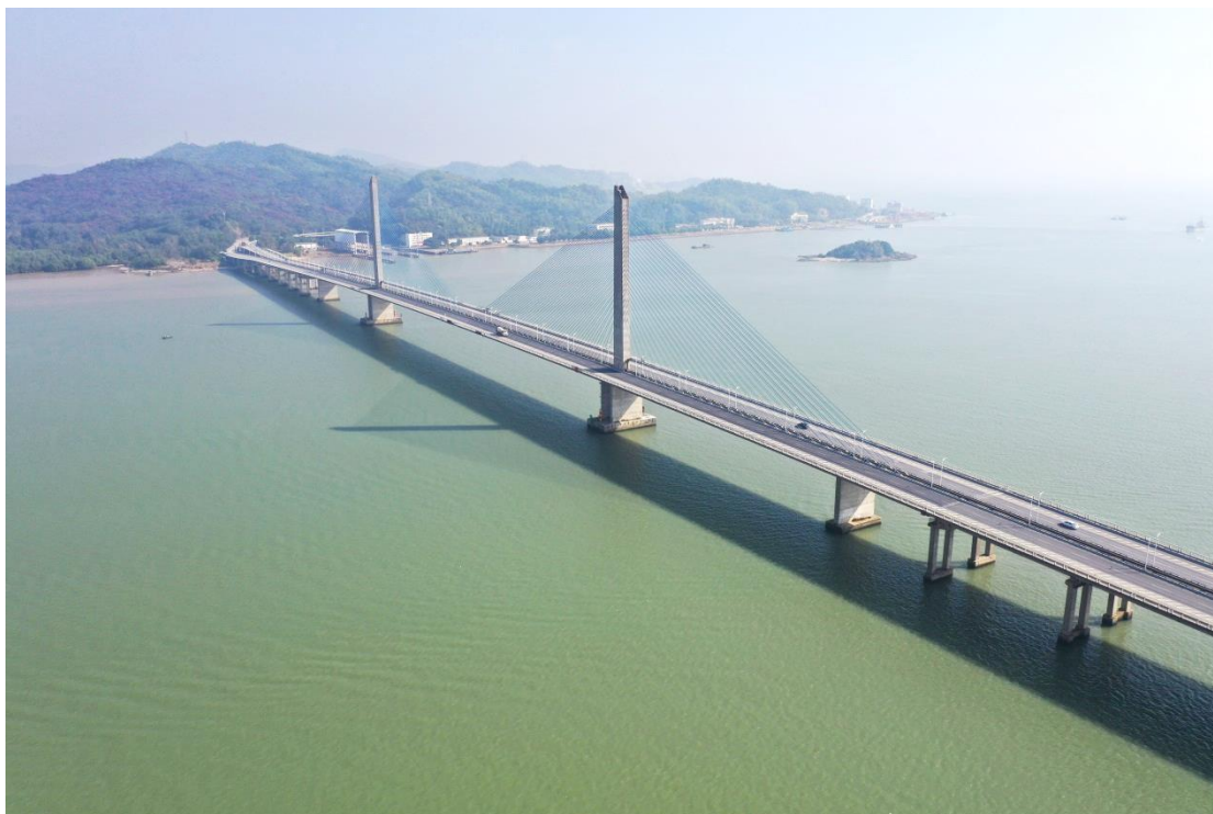
图 2.2-1 淇澳大桥现状图
