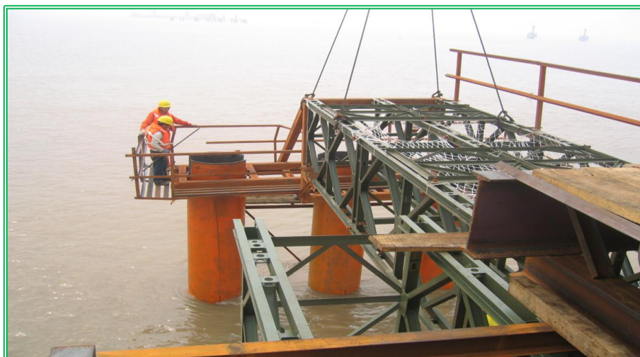
图 2.3-2 平台钢管桩沉桩现场施工照片
