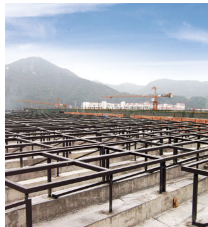
◀ 混凝土 屋面支架
