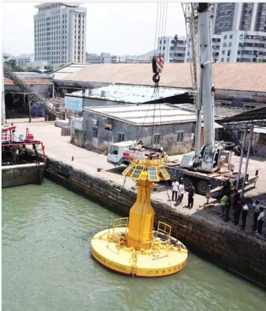
图 2.3.1-1 浮标吊装下水工作图
