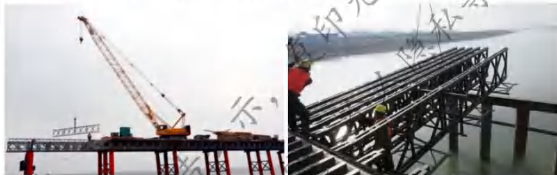
图 1.6.2-2 贝雷梁架设
