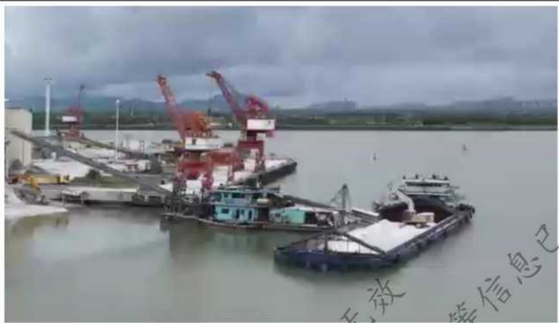
图 1.4.3-2 西侧高桩梁板式整体现浇结构件杂码头
