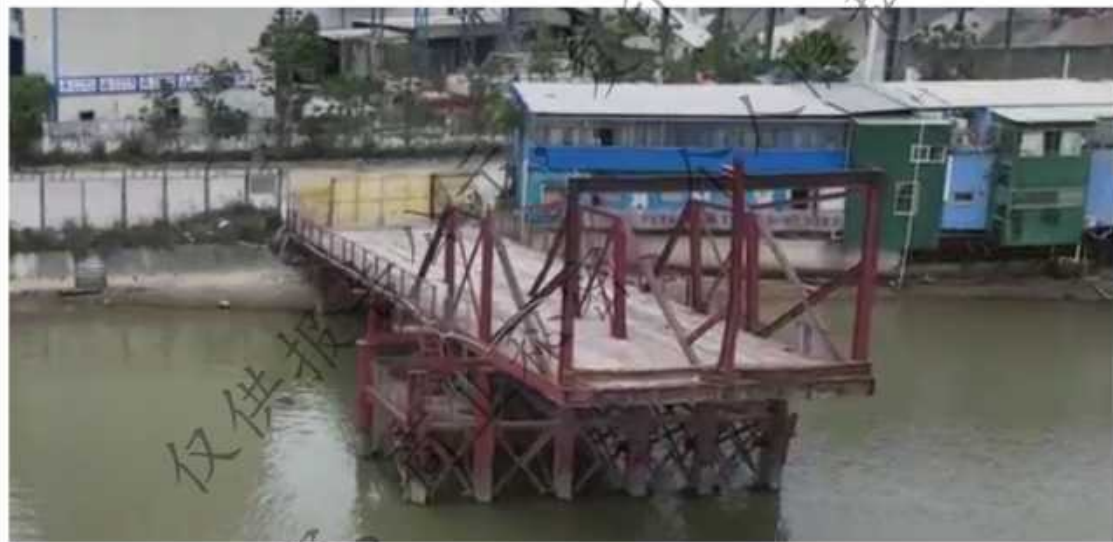
图 1.4.3-3 西侧往东方向第一座钢栈桥码头
