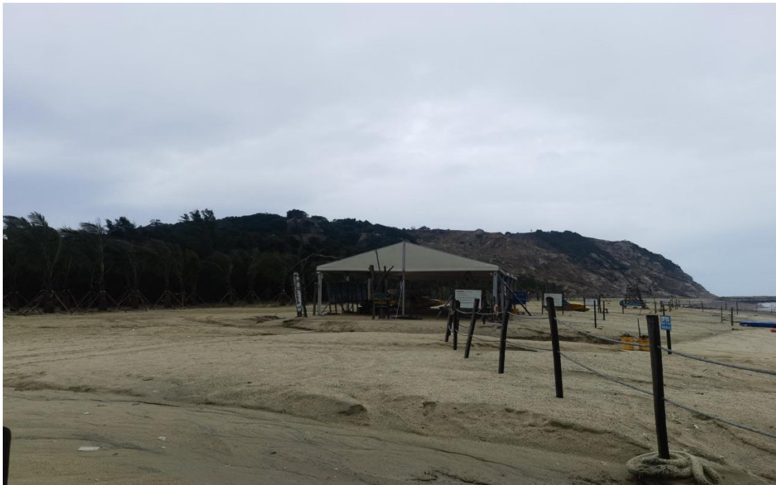
图 4.2.1-3 珠海市桂山岛海豚湾沙滩修复工程现状图
