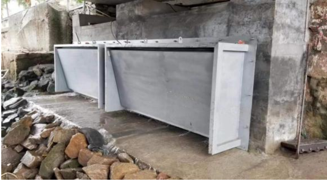
图 2.2.1-12 液动旋转堰门
