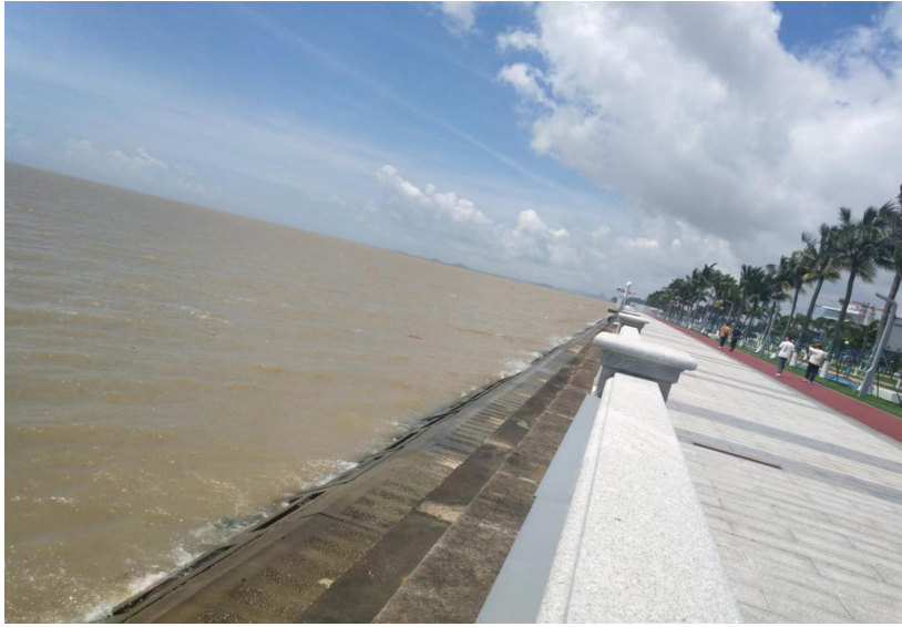
图 5.1.2-2 珠海高新区情侣北路东段海堤现状（摄于 2024 年 6 月）
