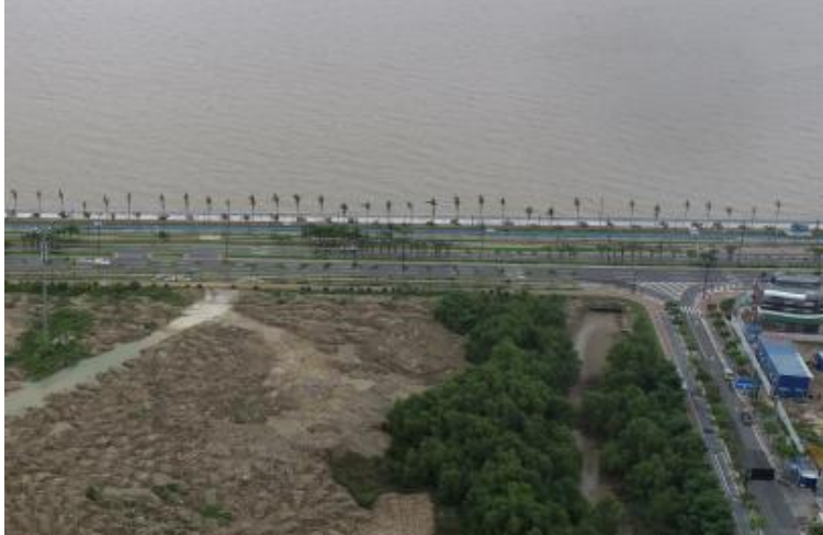
图 1.1.7-1 情侣北路海堤及山塘现状情况
