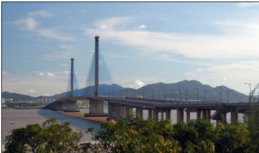
图 4.1.2-4 淇澳大桥现状照片
