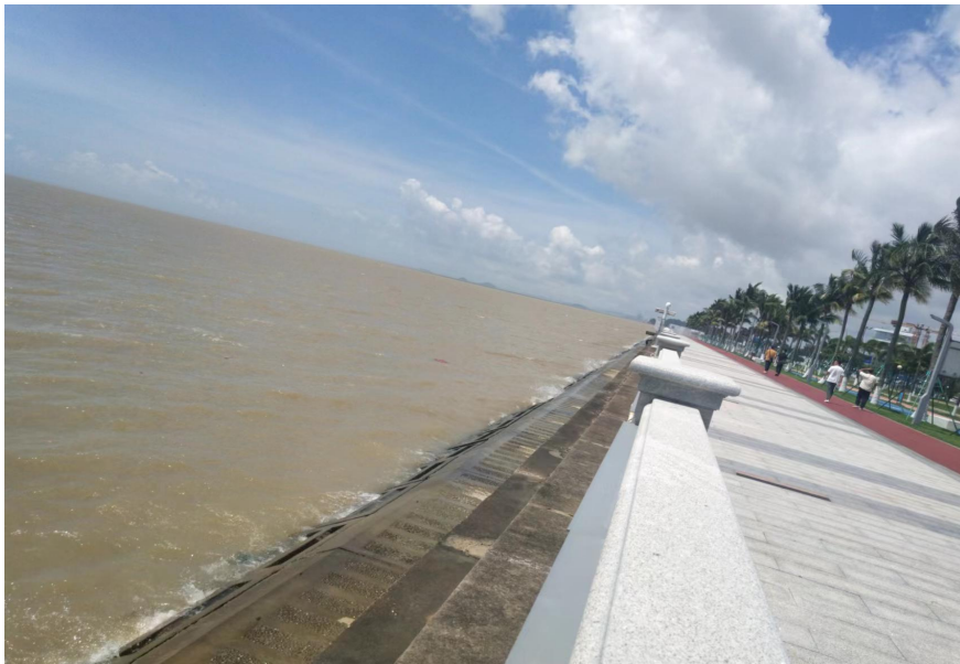
图 4.1.2-2 珠海高新区情侣北路东段海堤现状(摄于2024年6月)
