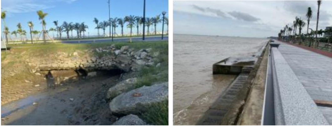
图 1.1.4-6 渠道末端 2-4×1.5m 箱涵及外海 2-2.5×2.5m 箱涵
