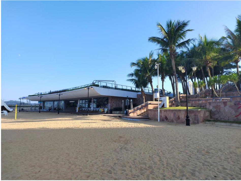
图 2.1.1-1 项目后方陆域公共基础设施
