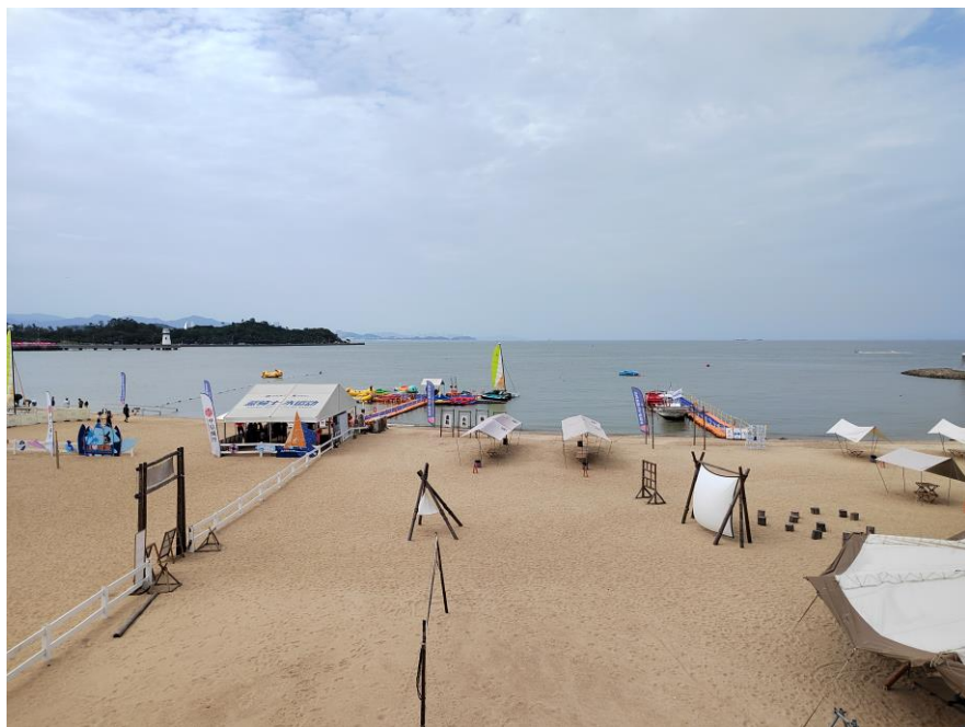
图 5.1.2-3 珠海市海滨泳场改造提升工程现场照片
