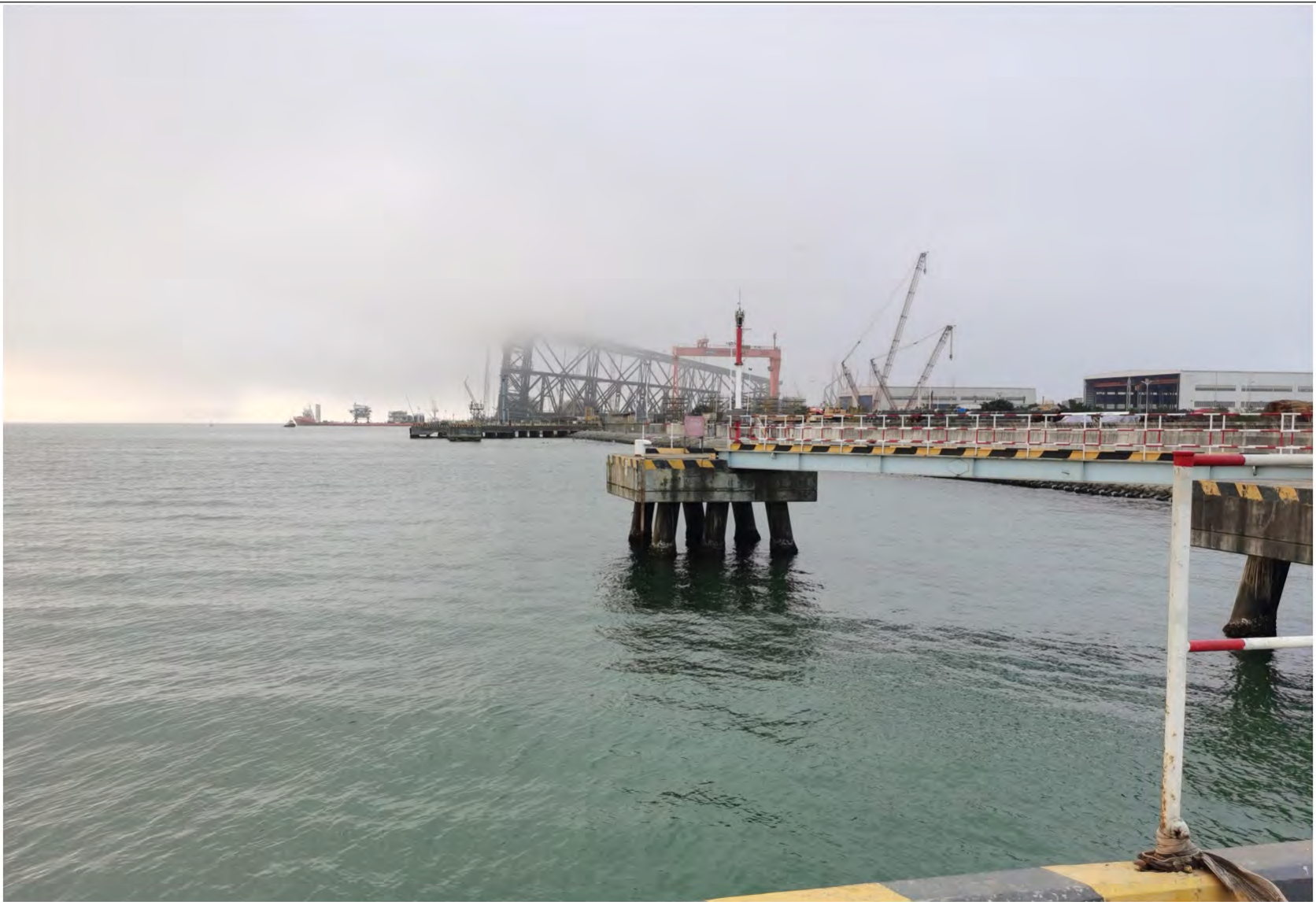
图 5.1.2-4b 现状码头东侧现状图
