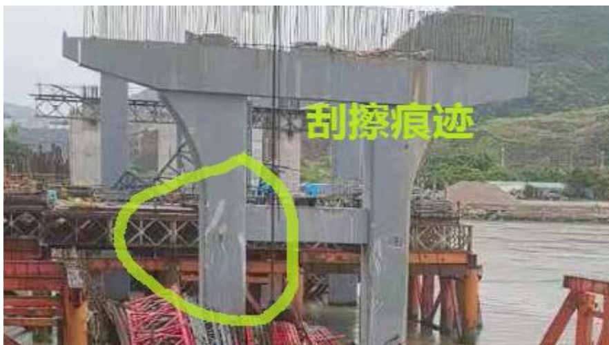
图 5：支架垮塌对挂篮的破坏
