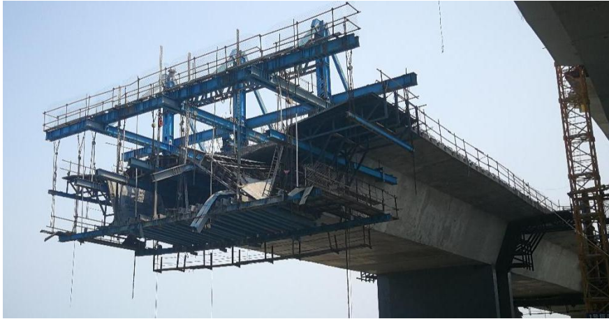
图 5：支架垮塌对挂篮的破坏
