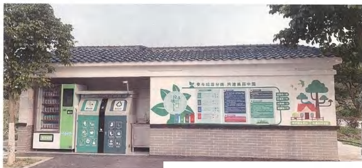
碧潭村生活垃圾分类收集房
